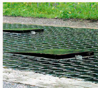
Трамплины мы сделали депрессивными, чтобы не повредить базальтовую плитку, под них проложены эластичные коврики
